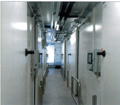
Die Räume für die Pilzzucht und anschließende Weiterverarbeitung errichtete das G+H Team in Paneelbauweise.
