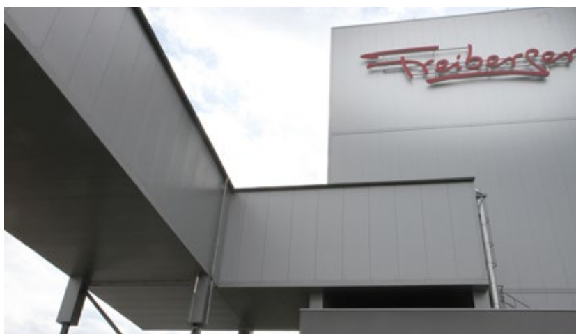
Die Verbindungsbrücke zwischen Hauptgebäude und Tiefkühlager ist mit Schleusen zur Abtrennung des inertisierten Bereichs und einer Brandschutzwand ausgestattet.
