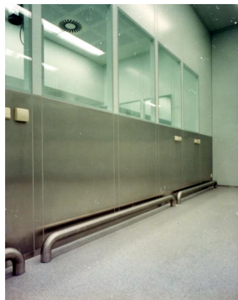
Wand mit Verglasung; Ausführung teilweise in Edelstahl
