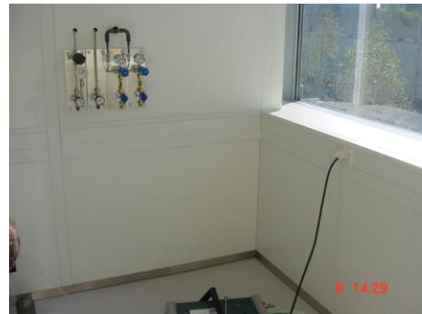
Sondereinbauten: Integrierter Kabelkanal, Mediendurchführung
