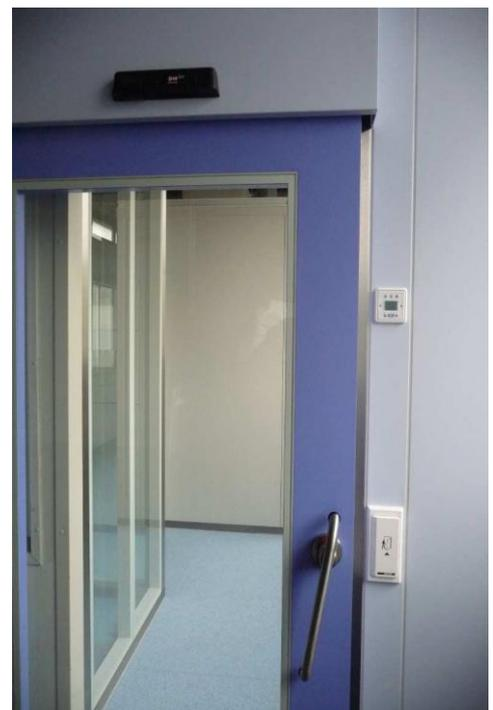
Automatisierte Schiebetür mit Bedienungseinheit und Sensorleiste
