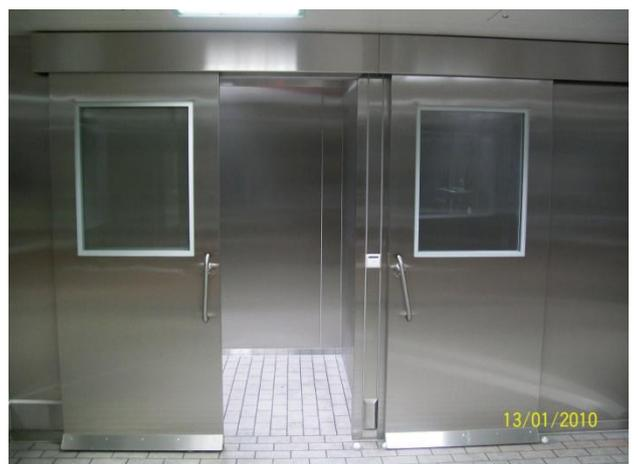
Dichtschließende Schiebetür in Edeldstahlausführung
