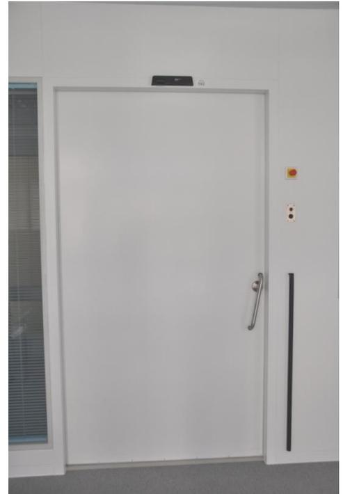
Automatisierte Schiebetür mit Rot-Grün Anzeige, Not-Aus Schalter sowie Schlagleiste
