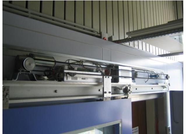
Laufschiene mit Antriebs- und Steuerungseinheit
