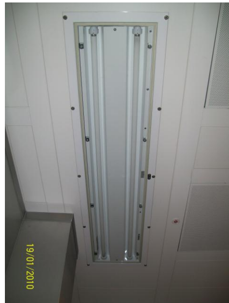
Ausführung: Ex-Einbauleuchte in Sonderkassette mit 100 mm breiten Alu-Profilen
