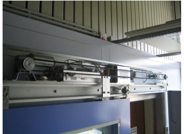
Laufschiene mit Antriebs- und Steuerungseinheit
