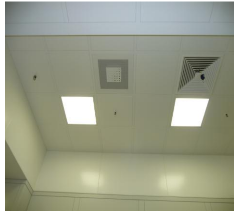
Ausführung: Raster 665x665 mm, Öffnung 625x625 mm mit 40 mm breiten Alu-Profilen, Kassetten Stahlblech, Oberflächen beschichtet, mit Einbauten
