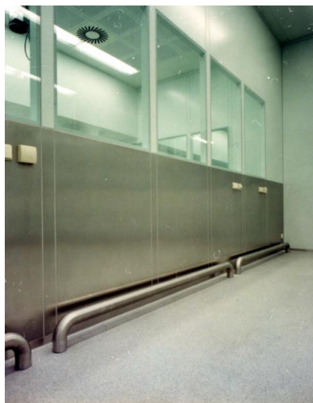
Wand mit Verglasung; Ausführung teilweise in Edelstahl
