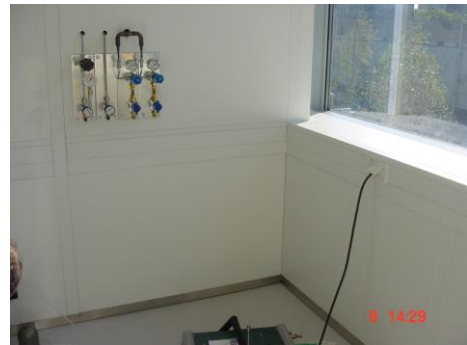
Sondereinbauten: Integrierter Kabelkanal, Mediendurchführung
