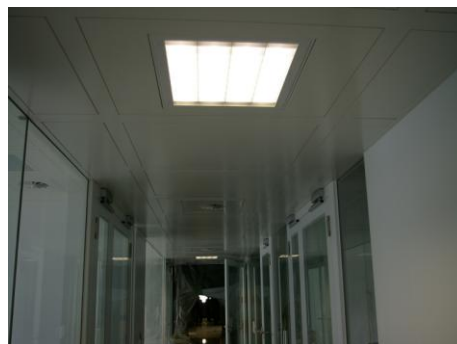
Ausführung: Raster 1200x1200 mm, Öffnung 1100x1100 mm, Ausschnitt für Einbauten 625x625 mm in Kasette, Kassetten Stahlblech, Oberflächen beschichtet, mit Einbauten
