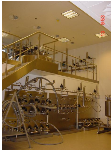
Ansatzraum, h=4.500 mm; Medienwand als Stahlrohrkonstruktion
