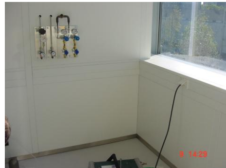
Sondereinbauten: Integrierter Kabelkanal, Mediendurchführung
